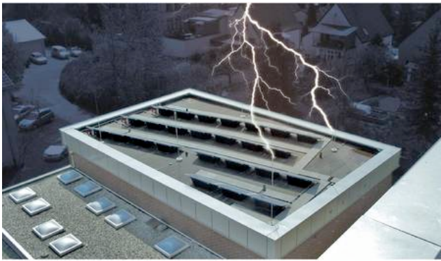
Fangstangen schützen zwar vor direktem Blitzschlag, nicht aber vor Überspannung. Dazu benötigt man Ableiter vom Typ II, für die es neue Lösungen gibt. Foto: Dehn + Söhne
